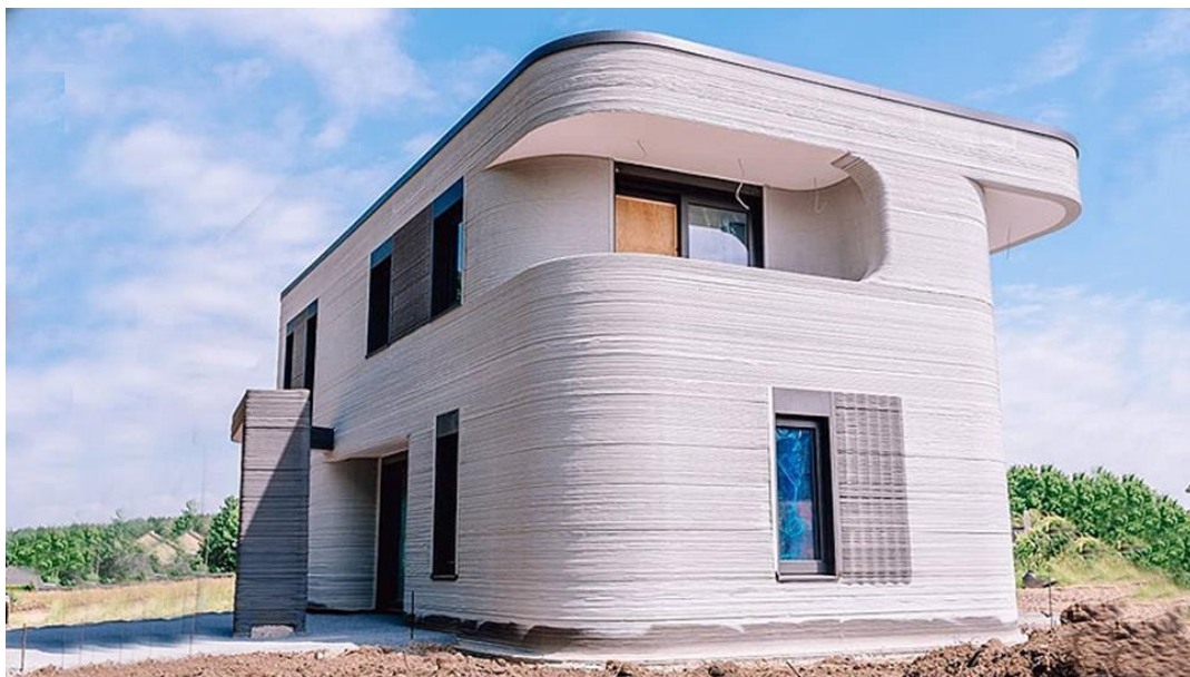
ภาพที่ ๒ อาคารหลังแรกในประเทศเยอรมนีที่พิมพ์ด้วยเครื่องพิมพ์ ๓ มิติ ซึ่งใช้เวลาพิมพ์เพียง ๑๐๐ ชั่วโมง เป็นอาคารที่มีพื้นที่ใช้งาน ๓๘๐ ตารางเมตร ทั้งนี้ ส่วนที่พิมพ์คือผนังกำแพงแนวตั้งทั้งหมด ส่วนพื้นและบันไดหล่อจากโรงงานมาติดตั้ง จุดเด่นคือโปรแกรมสามารถพิมพ์โดยเว้นช่องว่างตามตำแหน่งที่มีท่อวางระบบเดินผ่าน (ภาพจาก https://interestingengineering.com/germanys-first-3d-printed-residential-building-is-near-completion )
