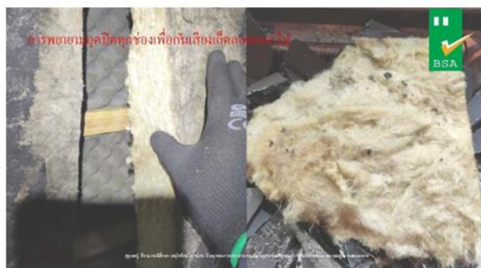
ภาพที่ ๒ การตรวจสอบหลังเพลิงไหม้ พบการใช้วัสดุติดไฟดูดตามช่องเปิดตามผนังเพื่อกันเสียงเล็ดลอดออกนอกอาคาร [ภาพโดยความอนุเคราะห์ของสมาคมผู้ตรวจสอบอาคาร]
