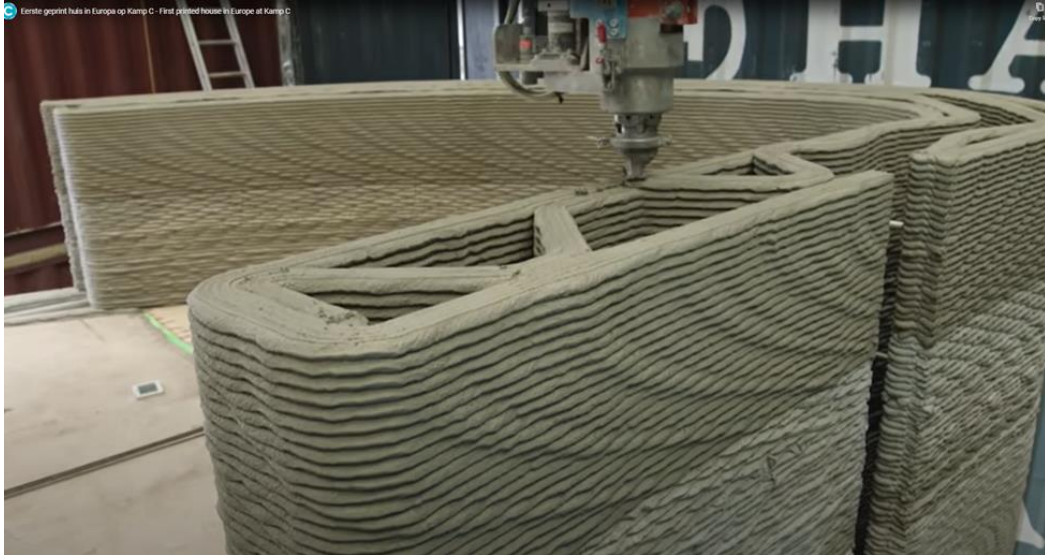
ภาพที่ ๑ หัวพิมพ์เครื่องพิมพ์ ๓ มิติ BOD2 ที่สามารถพิมพ์ในระนาบด้วยความเร็ว ๑ เมตรต่อวินาที ส่วนวัสดุที่ใช้พิมพ์เป็นคอนกรีตส่วนผสมพิเศษ i.tech 3D ที่พัฒนาโดยบริษัท HeidelbergCement สำหรับงานพิมพ์ ๓ มิติโดยเฉพาะ (ภาพจาก https://www.designboom.com/architecture/kamp-c-3d-prints-two-story-house-08-17-2020/ )
